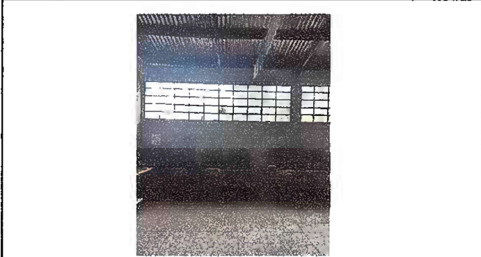
Foto1: Módulo 1: sustitución de vidrios
