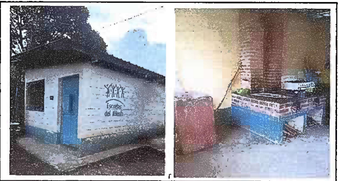
Foto 6: Módulo 6, suministro e instalación de balcones de metal, sustitución de piso de concreto por piso cerámico, sustitución de pila de concreto de un ala por pila de dos alas y sustitución de plancha de metal.
