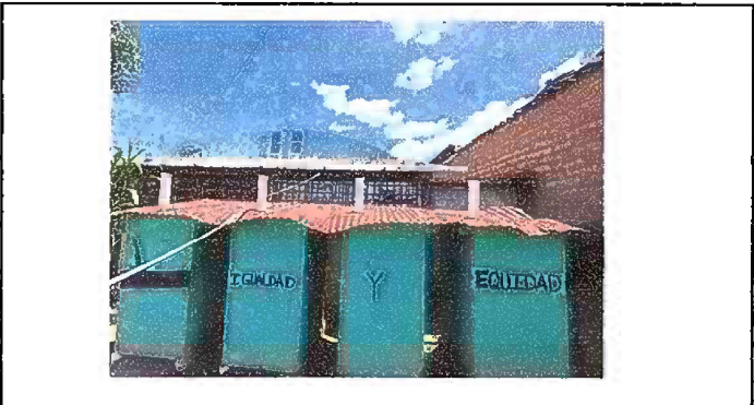
Foto 4: Módulo 4, sustitución de lámina por lámina troquelada aluzinc cal. 26.
