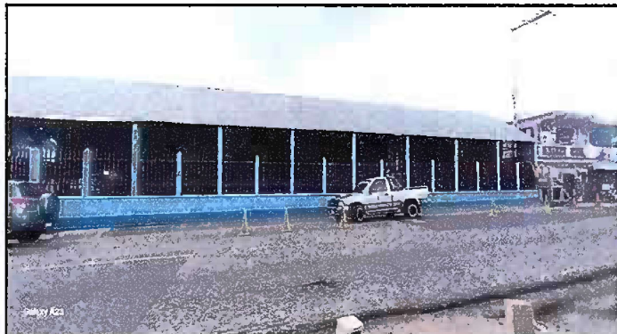
Foto 8: Módulo 3 (Muro perimetral) - Mantenimiento de baranda de metal.
