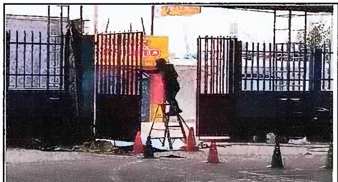
Foto 9: Módulo 3 (Muro perimetral) - Proceso de Mantenimiento a portones de metal.
