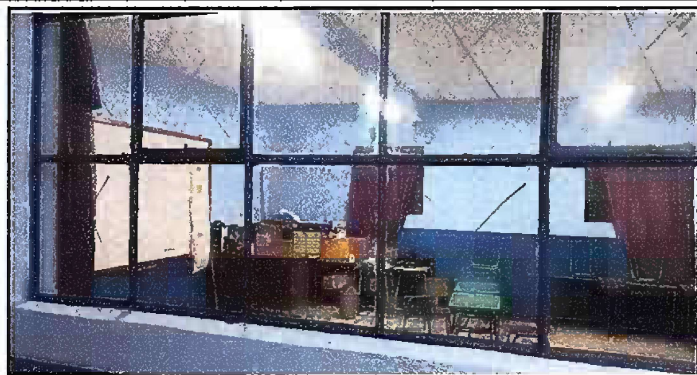
Foto 7: Módulo 2 (Planta alta y baja)- Sustitución de vidrios (ventanas).
