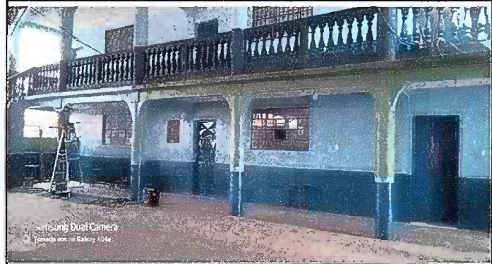
Foto 1: Módulo 1 (Planta baja y alta) - Mantenimiento de baranda de concreto.
