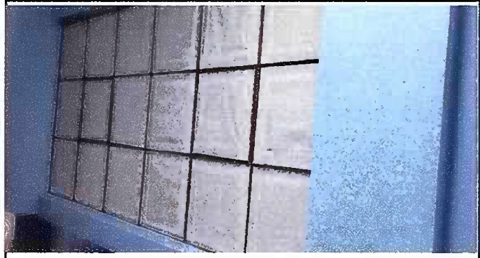
Foto 3: Módulo 1 (Planta baja y alta) - Mantenimiento a estructura de metal de ventana.
