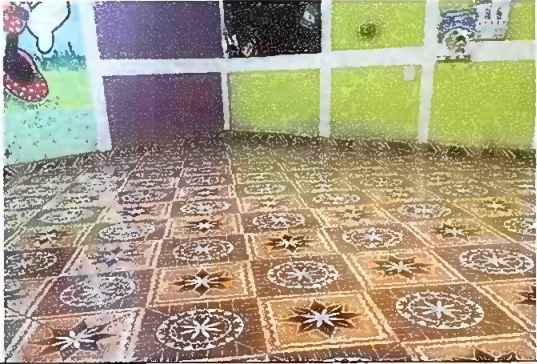
Foto1: Sustitución de pisos y sustitución de vidrios
