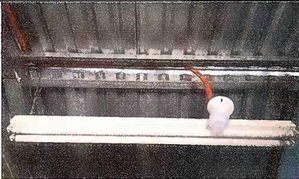
Foto 5: Sustitución de lamparas tipo LED y reparación de cableado eléctrico
