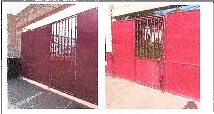
Foto 26: Mantenimiento a portones a metal (módulo 6)
