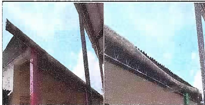
Foto 6: Sustitución de Canal de PVC a Metal (Modulo 2)
