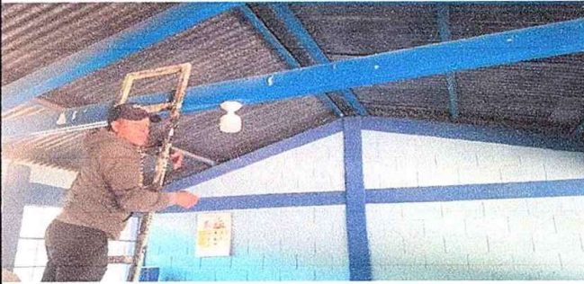
Foto 7: Modulo2. Sustitucion de focos ahorradores.
