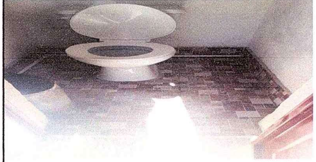
Foto 2: Modulo 1. Sustitucion Inodoro
