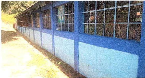
Foto 9: Modulo2. Pintura en muros exteriores e interiores.
