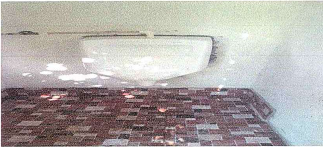
Foto 3: Modulo 1. Sustitucion de migitorio
