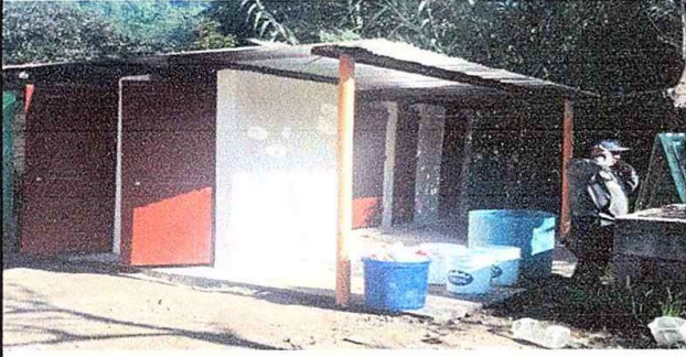
Foto1: Modulo 1. Sustitucion puerta de metal en baños
