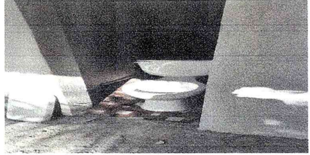
Foto 2: Modulo 1. .sustitucion inodoro
