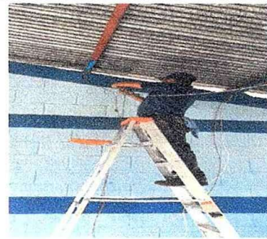
Foto 6:Modulo 2.Reparacion de cableado eléctrico.
