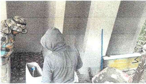
Foto 3:Modulo .1 .Sustitucion de Migitorio
