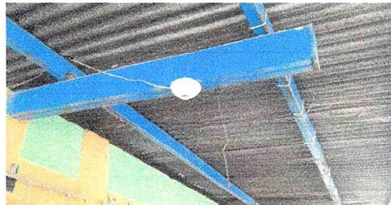
Foto 6: Modulo 2. Reparacion de cableado eléctrico.
