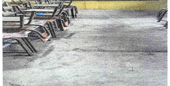
Foto .8: Modulo2. Sustitucion de piso de torta de concreto por piso cerámico.
