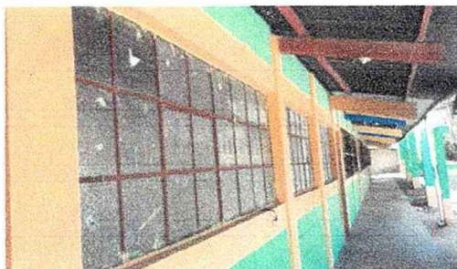
Foto 5: Modulo 2. Suministro e instalacion de balcon de hierro en ventana
