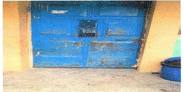
Foto 10: Modulo2. Mantenimiento a estructura de puerta (lijado, cambio de tubo, cepillado, sijecciones, aplicación de pintura)
