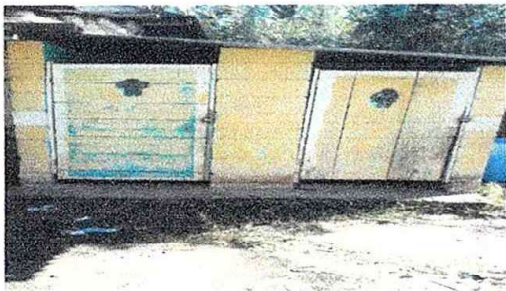
Foto1: Modulo 1. Sustitucion puerta de metal en baños
