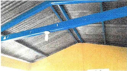
Foto 7: Modulo2. Sustitucion de focos ahorradores.
