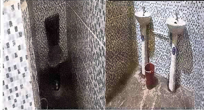
Foto 1: Modulo 1, sustitución de inodoros y lavamanos en sanitarios de niñas.
