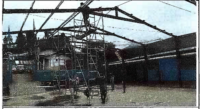
Foto 8: Modulo 5: sustitución de estructura de soporte de madera por metal
