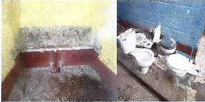
Foto1: Modulo 1, sustitución de inodoros y lavamanos en sanitarios de niñas.
