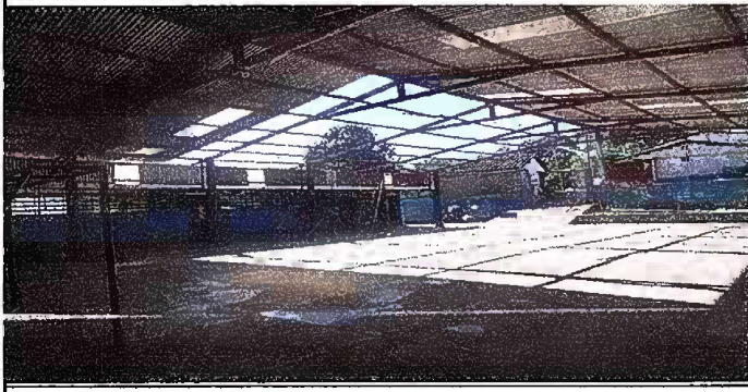
Foto 7: Sustitución de lamina
