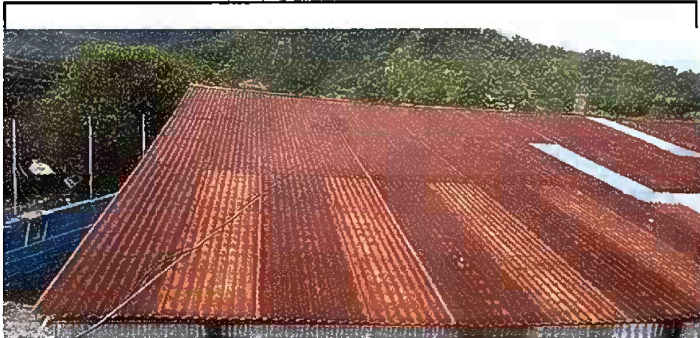
Foto7: Modulo 5, sustitución de laminas y sustitución de estructura de soporte de madera por metal
