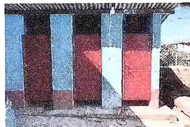
Foto 2: Sustitucion de puertas sanitaria
