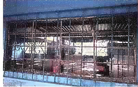
Foto 2: Mantenimiento de balcones de metal en aula
