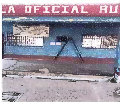
Foto 3: Sustitución e instalación de balcones en ventana de aula
