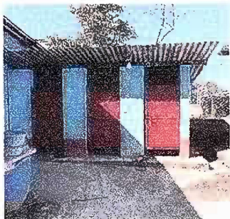
Foto 1: Sustitucion de puertas sanitaria
