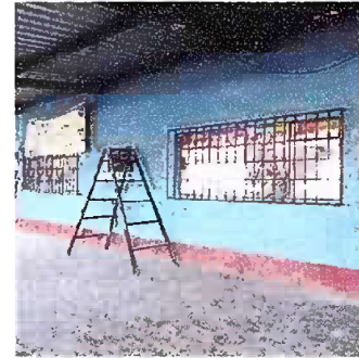
Foto 4: Sustitución e instalación de balcones en ventana de aula
