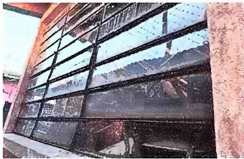
Foto 5: Sustitución de vidrios en aulas
