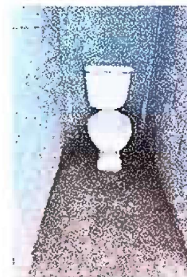
Foto 4: Sustitucion de inodoros
