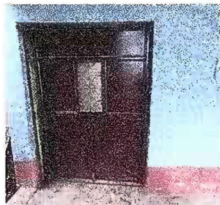
Foto 5: Mantenimiento de puerta de cocina
