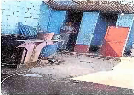
Foto1: Sustitucion de puertas sanitaria
