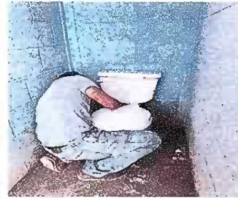
Foto 4: Sustitucion de inodoros
