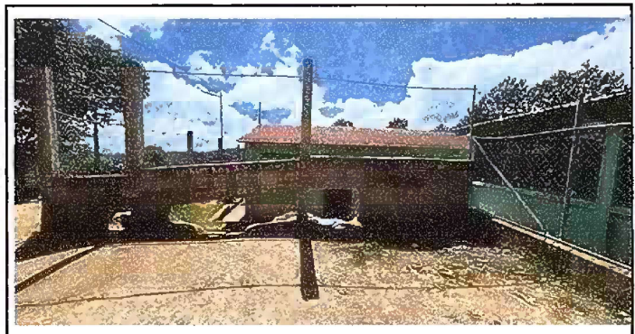
Foto 3: MURO PERIMETRAL: REPARACIÓN DE MURO PERIMETRAL DE BLOCK CON TUBO HG Y MALLA GALBANIZADA, SOLERAS INTERMEDIAS Y COLUMNAS.
