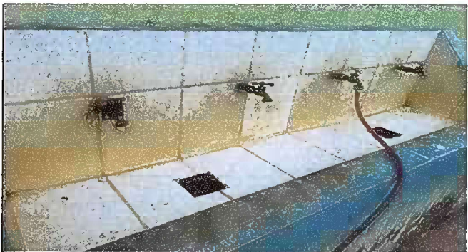
Foto 5: Módulo 5. Sustitución de llave de chorros y azulejos
