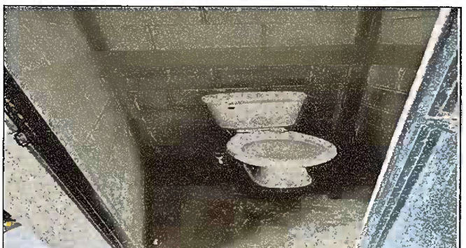
Foto 6: Módulo 5 Sustitución de inodoro
