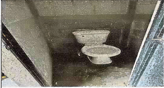
Módulo 5 Módulo 5 Sustitución de inodoro
