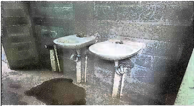
Foto 22: Módulo 5 Sustitución de lavamanos
