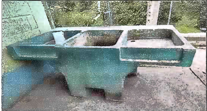
Foto 20: Módulo 5 Sustitución de pila de cemento de dos lavadero
