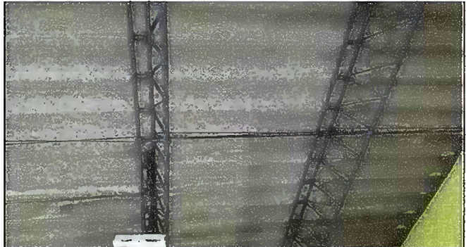
Foto 4: Módulo 2 Sustitución de estructura de soporte de metal, por metal
