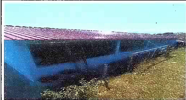
Foto 6: Modulo 3 trabajos Finalizados de la Sustitución de 123 M2 de Lámina por Lámina Troquelada de Aluzinc parte tracera.
