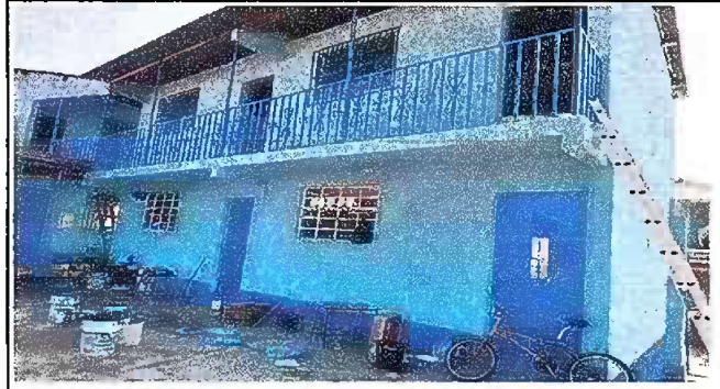
Foto 2: Modulo 1 Ya Finalizados los Trabajos de Remosamiento a un 100% en el Establecimiento Educativo.
