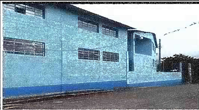
Foto7: Modulo 1, Finalizado a un 100 % el Pintado de Muros Exteriores e Interiores
