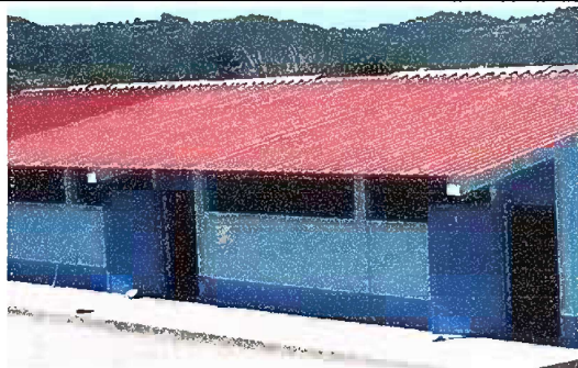
Foto 5: Modulo 3 Trabajos Finalizados de la Sustitución de 123 M2 de Lámina por Lámina Troquelada de Aluzinc parte de frontal.
