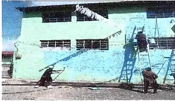
Foto1: Modulo 1 En Ejecución el Pintado de Muros Exteriores.
