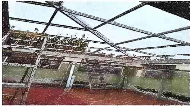
Foto 3: Modulo 2 durante el Proceso de los Trabajos de la Sustitución de Soporte de Madera por Soporte de Metal.
