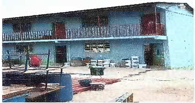
Foto 2: Modulo 1 En Ejecución el Pintado de Muros Interiores, barandas y puertas.
