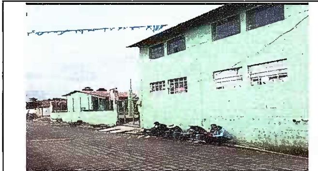
Foto1: Modulo 1 antes de iniciar los trabajos de remozamiento. ( Pintura de Muros Exteriores e Interiores)
