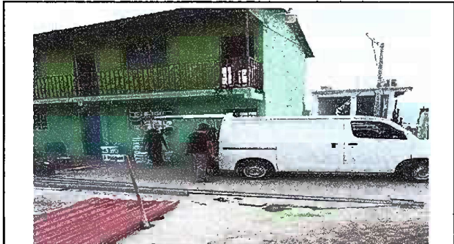
Foto 2: Modulo 1 antes de iniciar los trabajos de remozamiento. ( Pintura de Muros Exteriores e Interiores, pintado de barandas y puertas)
