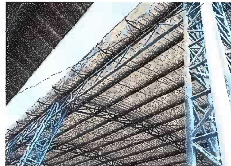
Foto 6: Módulo 2 Sustitución de soporte de metal para canal (pescantes)
