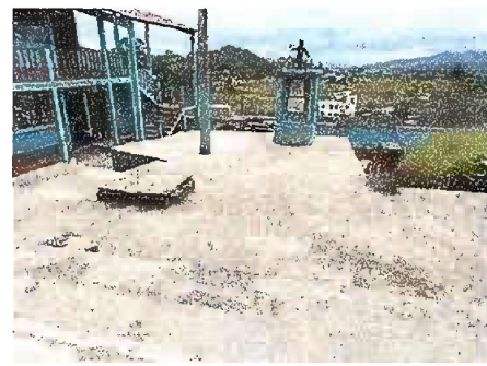
Foto 4: Patio Reparación de planchas de concreto
