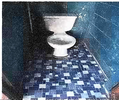
Foto 9 : Módulo 3 Instalación de inodoro
