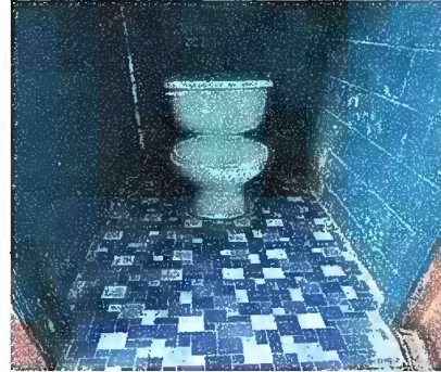
Foto 8 : Módulo 3 Sustitución de inodoro
