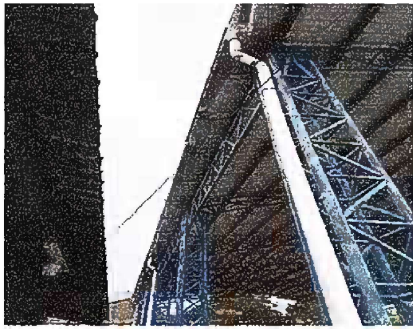
Foto 7 : Módulo 2 Reparación de bajada de agua pluvial tubo PVC 3"
