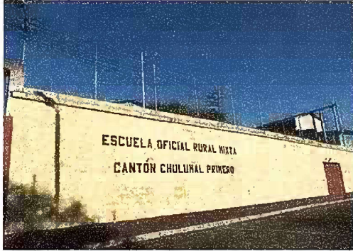
Foto 1: Muro Perimetral Reparación de tubo HG y malla galvanizada
