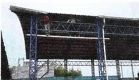
Foto 5: Módulo 2 Sustitución de Canal de metal
