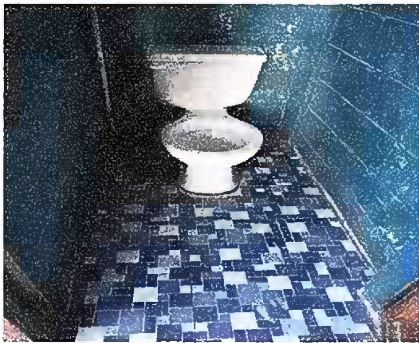
Foto 9 : Módulo 3 Instalación de inodoro
