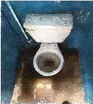
Foto 9 : Módulo 3 Instalación de inodoro
