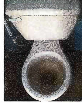
Foto 8 : Módulo 3 Sustitución de inodoro
