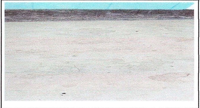
Modulo 2: Sustitucion de piso de concreto por ceramico.
