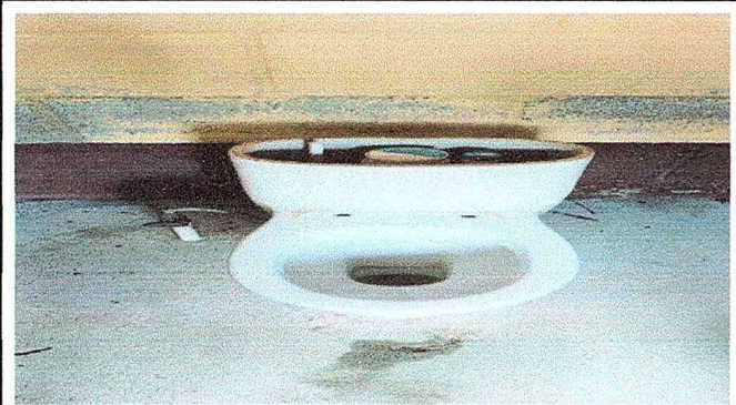
Modulo 1: Colocacion de ceramico y cambio de sanitario
