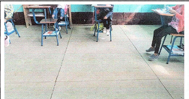
Modulo 3: Sustitucion de piso de concreto por ceramico.
