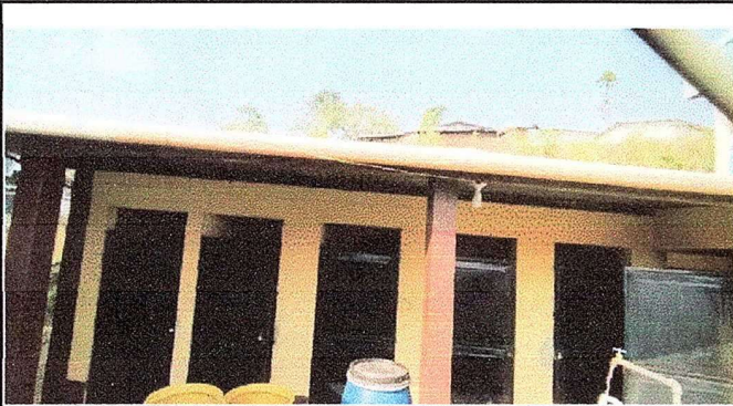
Modulo 1: Sustitucion de estructura de soporte de madera por metal
