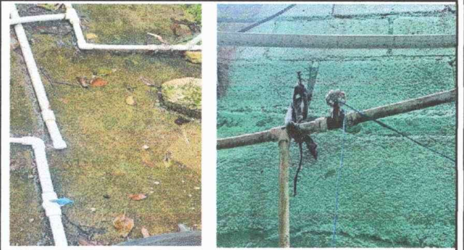
Foto 2, Modulo 2: Sustitución de llave de paso por llave de bola PVC
