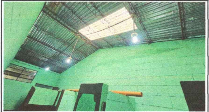
Foto 4, Modulo 2: Sustitución de focos ahorradores
