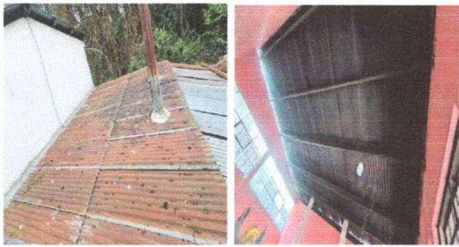
Foto 7 Modulo 1: sustitución de lamina por lamina troquelada aluzinc cal. 26
