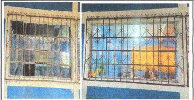
Foto 6, Modulo 3: Mantenimiento a balcones de metal.
