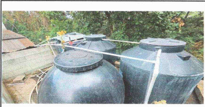
Foto 18, Modulo 2: Sustitución de depósito de agua 2500 lt
