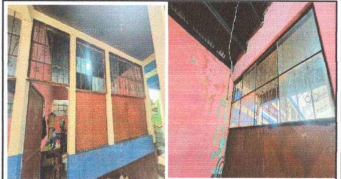
Foto 8, Modulo 1: Sustitución de vidrios
