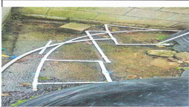
Foto 1, Modulo 2: sustitucion de tuberia de linea principal
