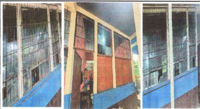
Foto 15, Modulo 1: Mantenimiento a balcones de metal.
