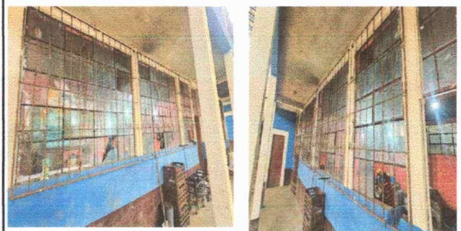
Foto 12, Modulo 1: Mantenimiento a balcones de metal.
