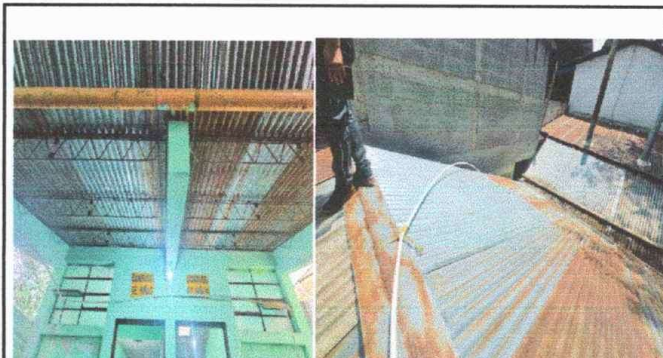
Foto 16. Modulo 2: sustitución de lamina por lamina troquelada aluzinc cal. 26
