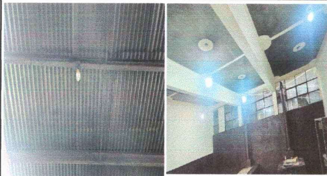
Foto 13, Modulo 1: sustitución de focos ahorradores
