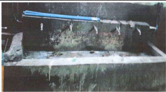
Foto 3, Modulo 2: sustitución de chorros
