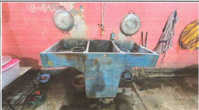
Foto 9: Módulo 1 sustición de lavadero de concreto grande
