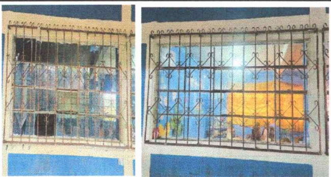
Foto 5, Modulo 3: sustitución vidrios
