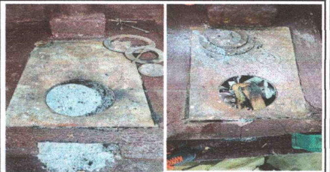
Foto 10, Modulo 1: Sustitución de plancha de metal de 4 hornillas
