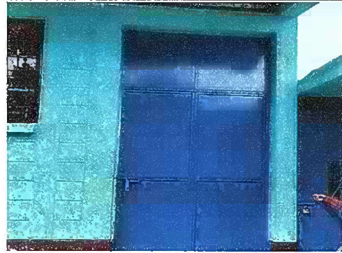
Foto 2: MODULO 1: Mantenimiento a estructura de puertas
