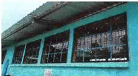
Foto 5: MODULO 1: Suministro e instalación de balcón de hierro en ventanas
