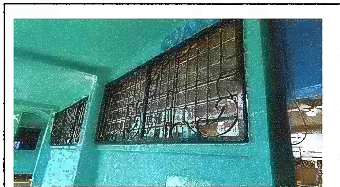
Foto 10: MODULO 3: suministro a instalación de balcon de hierro en ventanas
