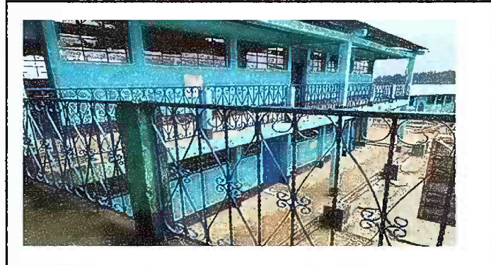
Foto 8: MODULO 2: Mantenimiento de barrandas de metal
