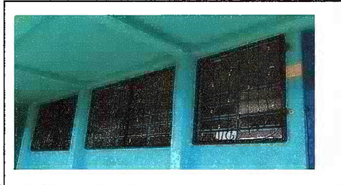
Foto7: MODULO 2: suministro e instalación de valcon de hierro en ventanas
