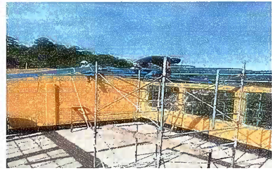
Foto 4: MODULO 1: sustitución de estructura de soporte de madera por metal
