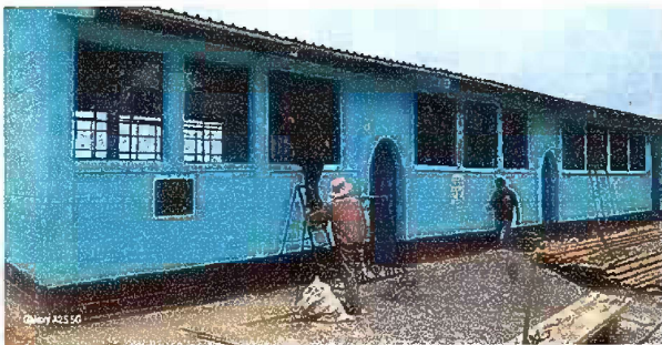
Foto 5: MODULO 1: Suministro e instalación de balcón de hierro en ventanas
