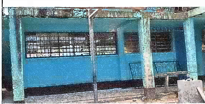
Foto7: MODULO 2: suministro e instalación de valcon de hierro en ventanas
