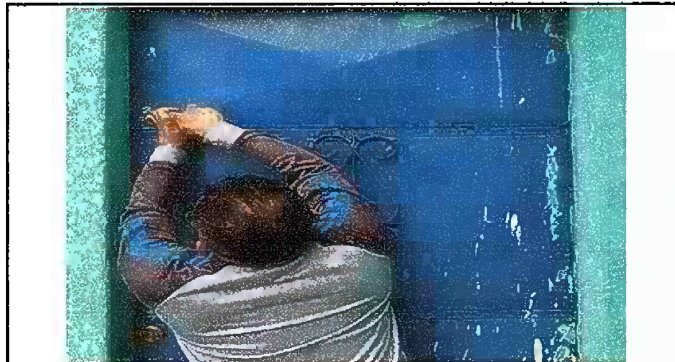
Foto 9: MODULO 3: Mantenimiento a estructura de puertas
