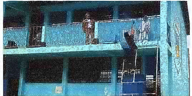
Foto 8: MODULO 2: Mantenimiento de barrandas de metal
