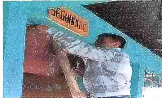
Foto 2: MODULO 1: Mantenimiento a estructura de puertas
