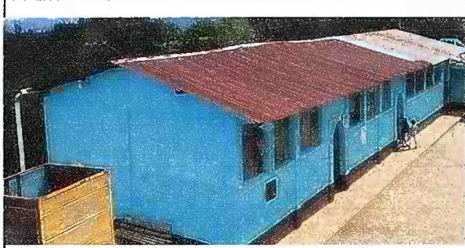
Foto 1: MODULO 1. Sustitución de láminas por laminas troqueladas calibre 26.
