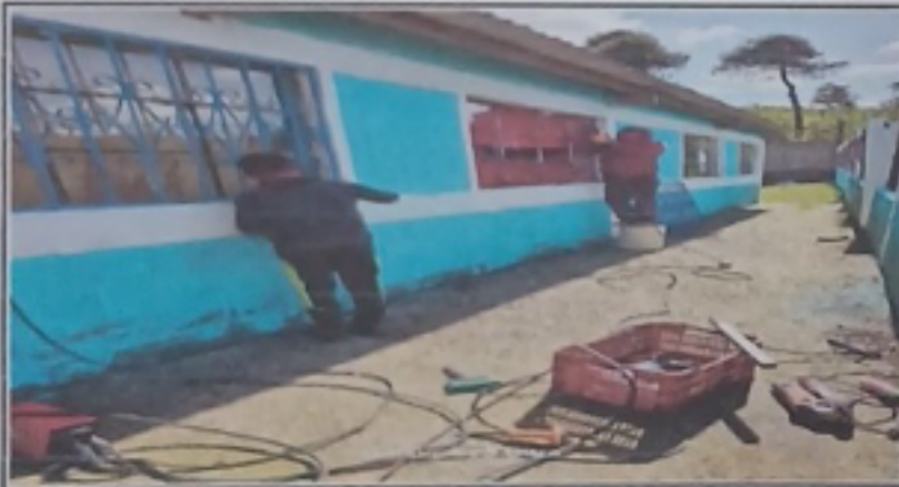
Foto 3: Suministro e instalaciones de balcones de metal en ventanas
