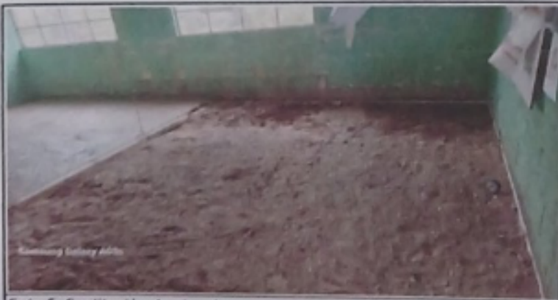
Foto 5: Sustitución de piso de torta de concreto de aula
