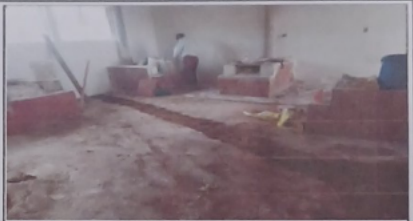
Foto 2: Sustitución de piso, Repello en muro y sustitución de planchas
