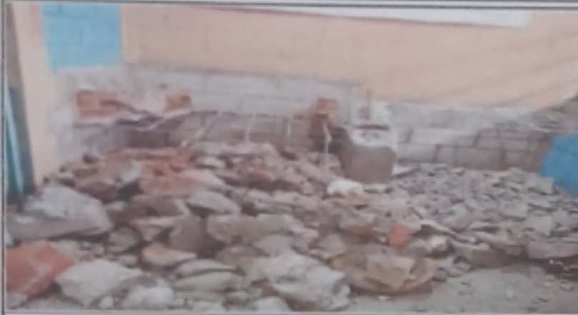
Foto 1: Sustitución de piso
