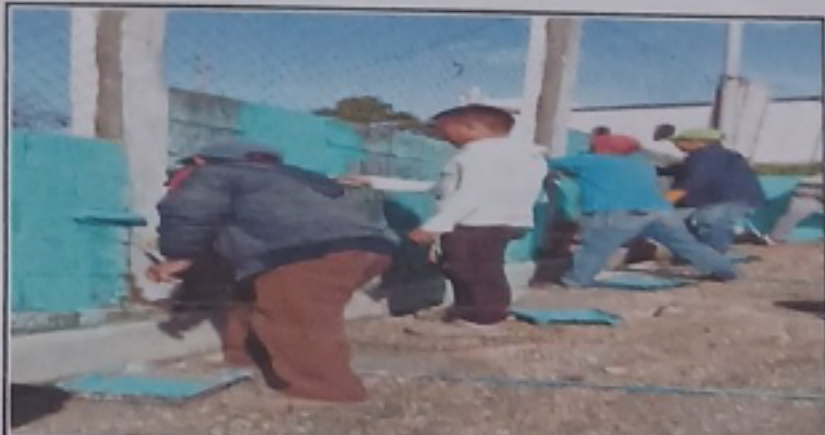
Foto 6: Pintura en muros exteriores e interiores
