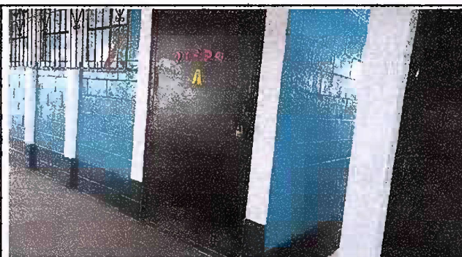
Foto 6: Modulo 2 Mantenimiento de puertas (En Proceso)
