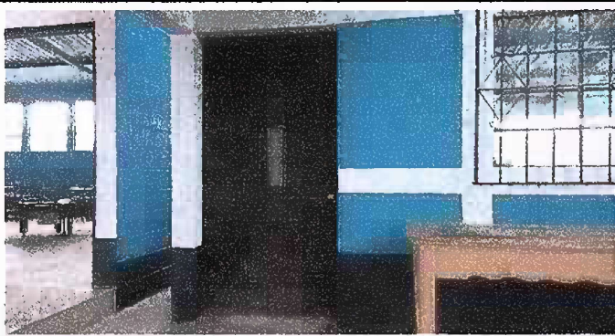
Foto 9: Modulo 3 Matenimiento de puertas (En Proceso)
