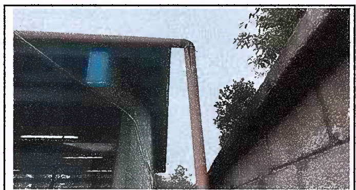
Foto 18: Modulo 6 Sustitución de canal de metal (En proceso)
