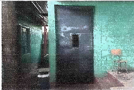
Foto 15: Modulo 5 Matenimiento de puertas
