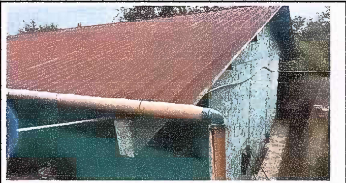
Foto 18: Modulo 6 Sustitución de canal de metal
