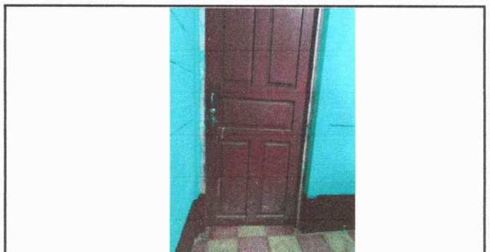
Módulo 2. Sustitución de puerta en la dirección
