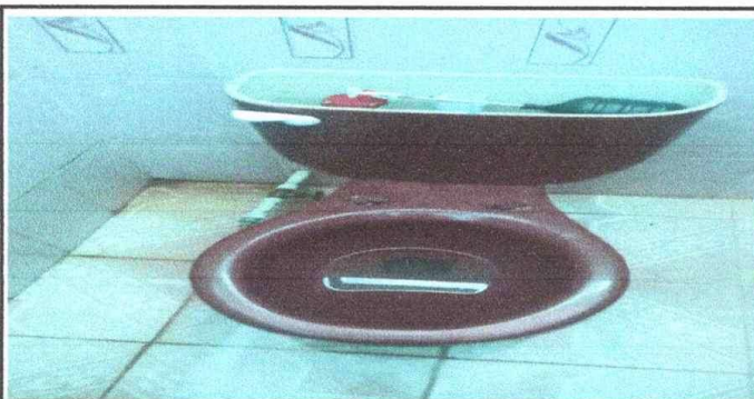
Módulo 2. Sustitución de 5 tazas
