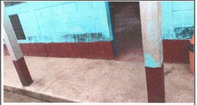
Módulo 1 sustitución de pisos en dos corredores
