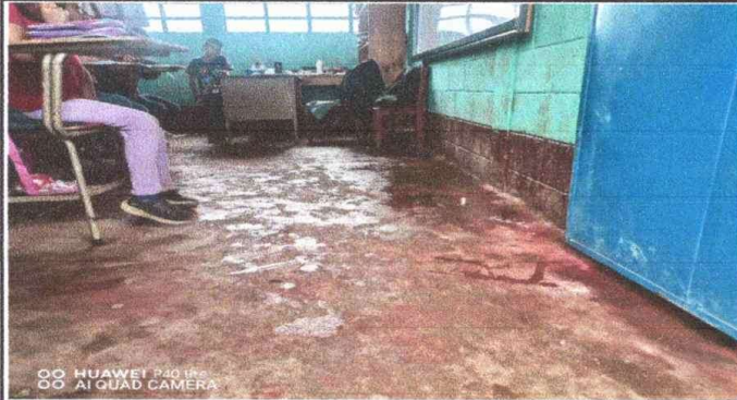
Módulo 1 Sustitución de piso en cuatro AULAS
