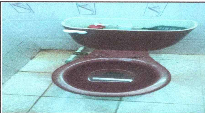
Módulo 1 Sustitución de de 6 tazas
