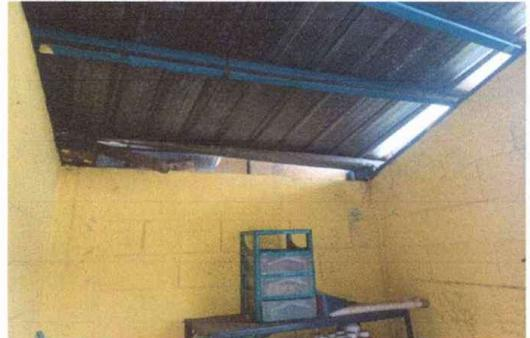
Foto 8. Modulo 4 : sustitución de lámina, por lámina troquelada aluzinc calibre 26, sustitución de capote de lámina por lámina troquelada, sustitución de elementos de fijación (tornillos)
