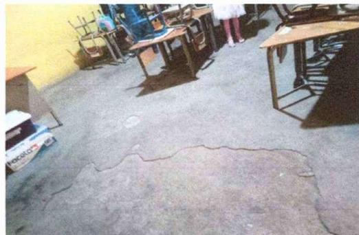
Foto 4. Modulo 1: Sustitución de piso de piso de torta de concreto
