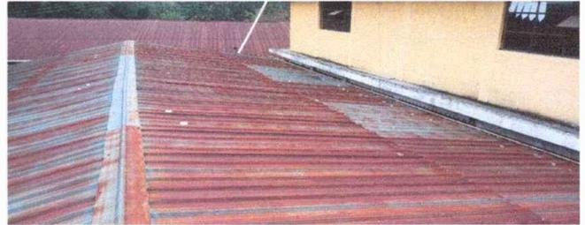
Foto 2. Modulo 1 : sustitución de lámina, por lámina troquelada aluzinc calibre 26, sustitución de capote de lámina por lámina troquelada, sustitución de elementos de fijación (tornillos)
