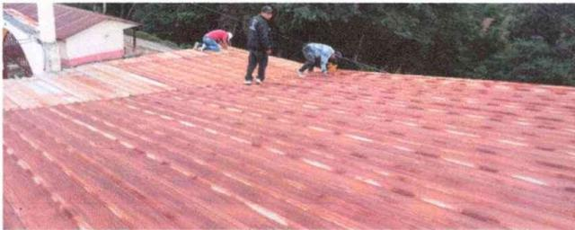
Foto 9. Modulo 3 : sustitución de lámina, por lámina troquelada aluzinc calibre 26, sustitución de capote de lámina por lámina troquelada, sustitución de elementos de fijación (tornillos)
