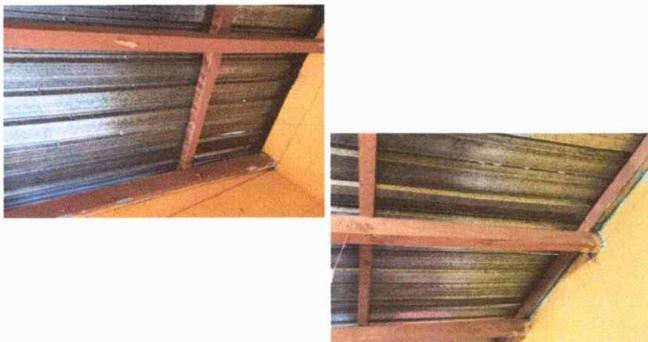
Foto 3. Modulo 1 : sustitución de lámina, por lámina troquelada aluzinc calibre 26, sustitución de capote de lámina por lámina troquelada, sustitución de elementos de fijación (tornillos), sustitución de soporte de
