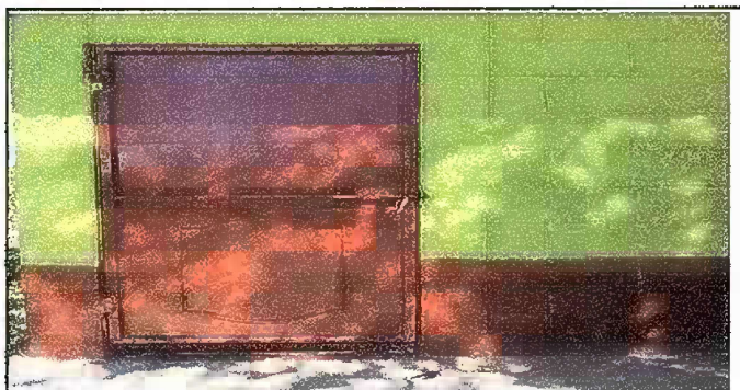
Foto 11: MODULO 3 MANTENIMIENTO DE ESTRUCTURA DE PUERTA DE METAL
