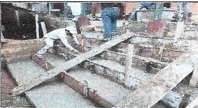
FOTO 12: PATIO RÉPARACIÓN DE TORTA DE CONCRETO DE PATIO (GRADAS Y PATIO)
