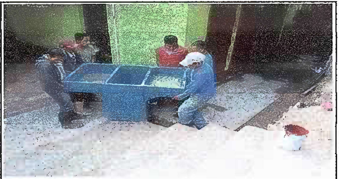
Foto 6: MODULO 1 SUSTITUCIÓN DE PILA
