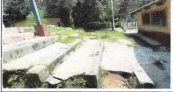
FOTO 12: PATIO REPARACIÓN DE TORTA DE CONCRETO DE PATIO (GRADAS Y PATIO)
