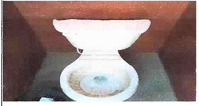
Foto 10: MODULO 2 SUSTITUCION DE INODORO
