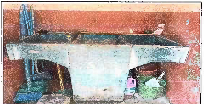
Foto 6: MODULO 1 SUSTITUCIÓN DE PILA
