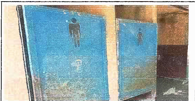
Foto 5: MODULO 1 MANTENIMIENTO DE ESTRUCTURA DE PUERTA DE METAL
