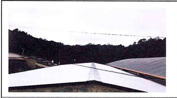
Foto1: Sustitución de láminas
