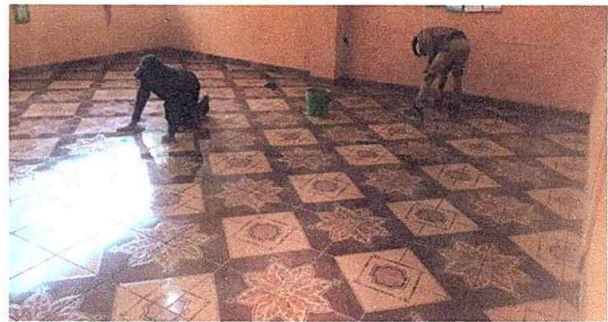
Modulo 3: Sustitución de piso concreto por piso cerámico.
