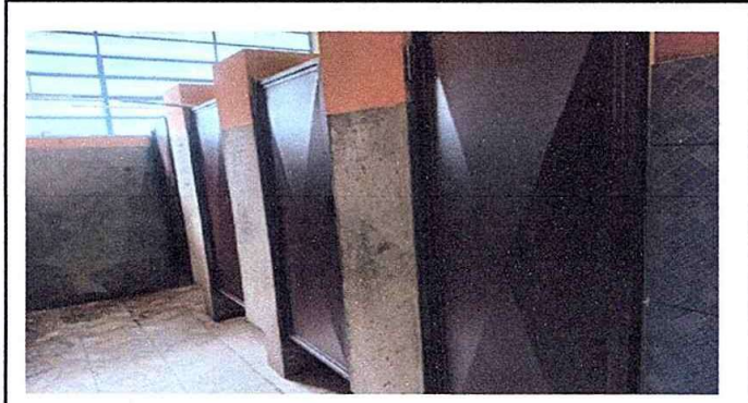
Modulo 2: Sustitución de puertas de servicios sanitarios
