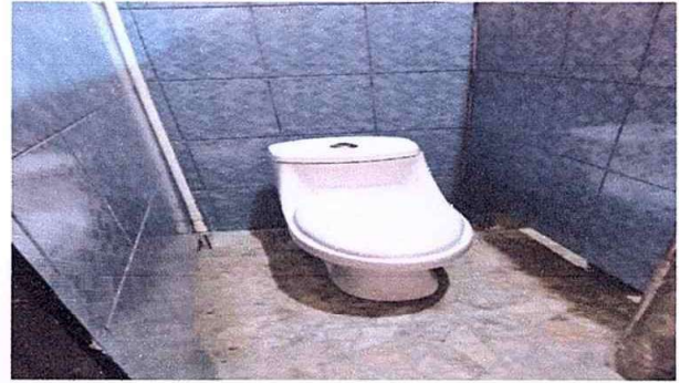
Modulo 2: Sustitución de inodoros, sustitución de azulejos
