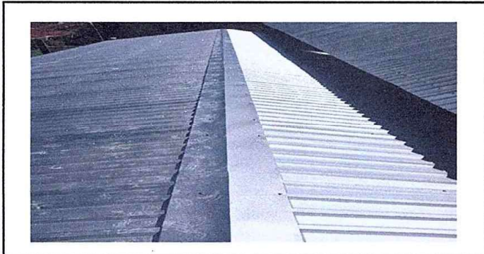
Modulo 4: Sustitución de láminas.
