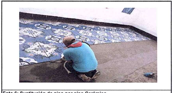
Foto 6: Sustitución de piso por piso Cerámico.
