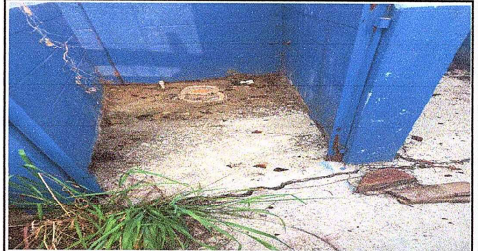
Foto 2: Modulo 5: Sustitución de piso de torta de concreto.
