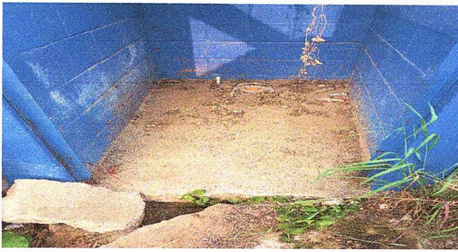
Foto 1: Modulo 5: Sustitución de puertas de metal en baños
