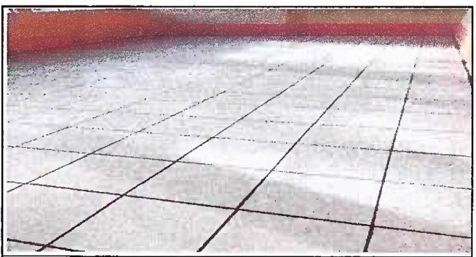
Foto 6 Modulo 3 Sustitucion de piso ceramico por piso ceramico
