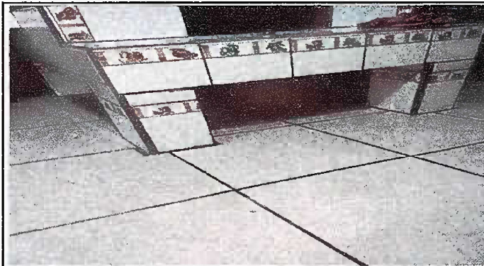
Foto 3: Modulo 2 Sustitucion de estufa rural completa incluyendo instalacion de azulejos a estufa rural
