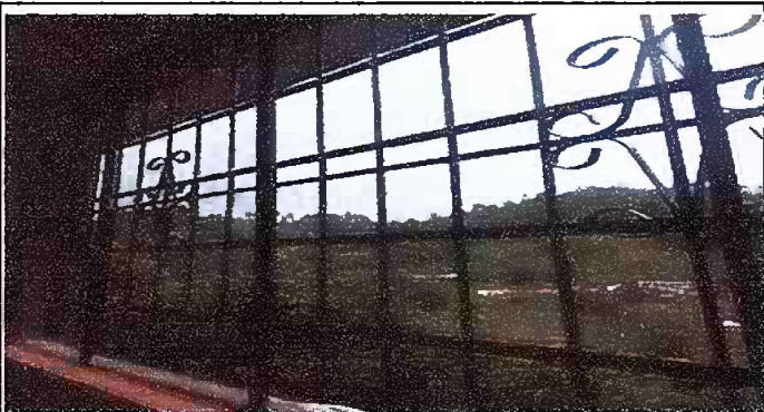
Foto 7: Modulo 3 Suministro e instalacion de balcones de hierro en ventanas
