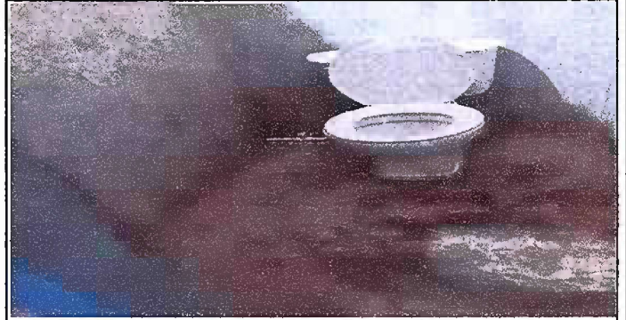
Foto 14 Modulo 5 Sustitucion de inodoro
