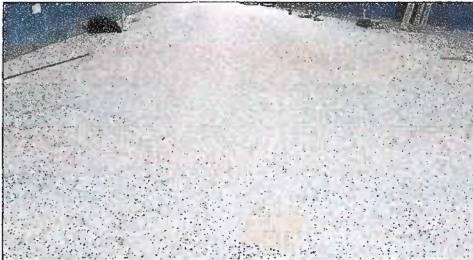
Foto 1: Modulo 1, Sustitución de piso de torta de concreto por piso granito.
