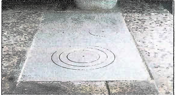
Foto 4: Módulo 2, Sustitución de plancha de metal de 3 hornillas.
