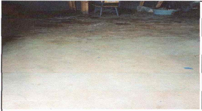
Foto 2: Módulo 2, Sustitución de piso de torta de concreto por piso granito.
