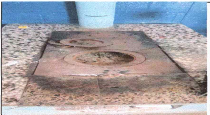
Foto 3: Módulo 2, Sustitución de plancha de metal de 3 hornillas.
