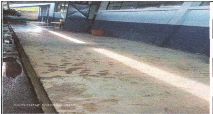
Foto 6: Módulo 5, Sustitución de piso de torta de concreto por piso granito.
