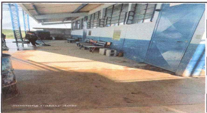
Foto 4: Módulo 3, Sustitución de piso de torta de concreto por piso granito.
