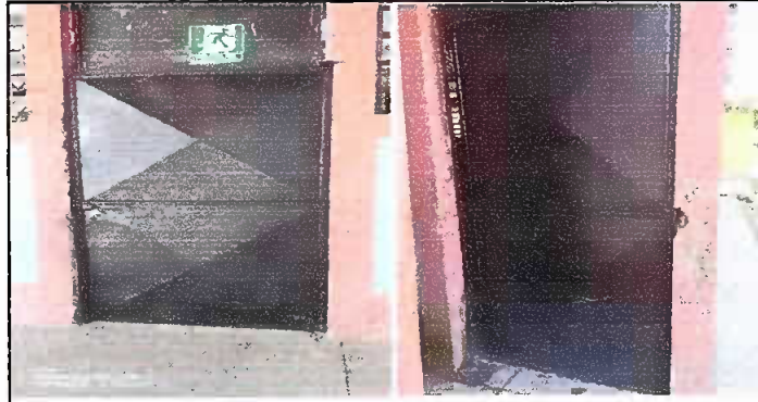
Foto 1: MODULO 1: Sustitución de puerta de metal.
