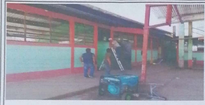
Foto1: MODULO 1: Sustitución de puerta de metal.
