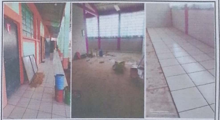
Foto 4: MODULO 2: Sustitución de torta de cemento por piso cerámico.
