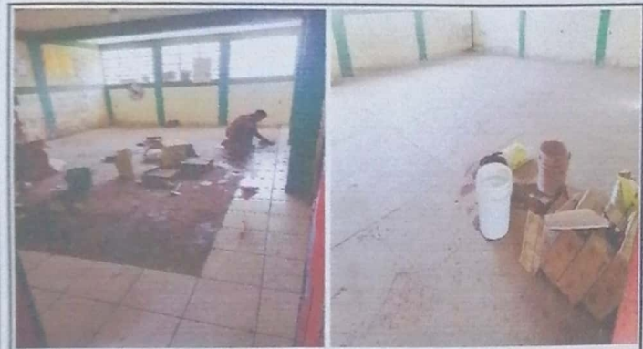
Foto 3: MODULO 2: Sustitución de torta de cemento por piso cerámico.
