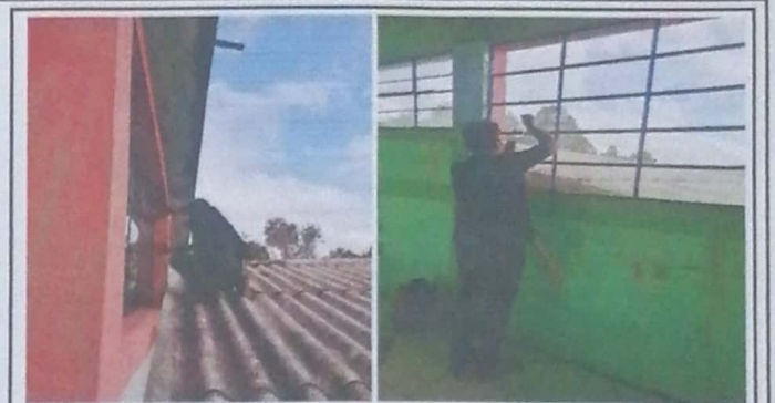
Foto 2: MODULO 2: Sustitución de ventanas y Sustitución de torta de cemento por piso cerámico.
