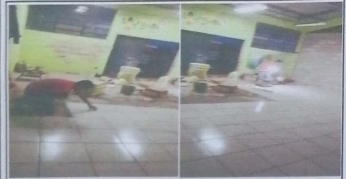
Foto 5: MODULO 3: Sustitución de torta de cemento por piso cerámico.
