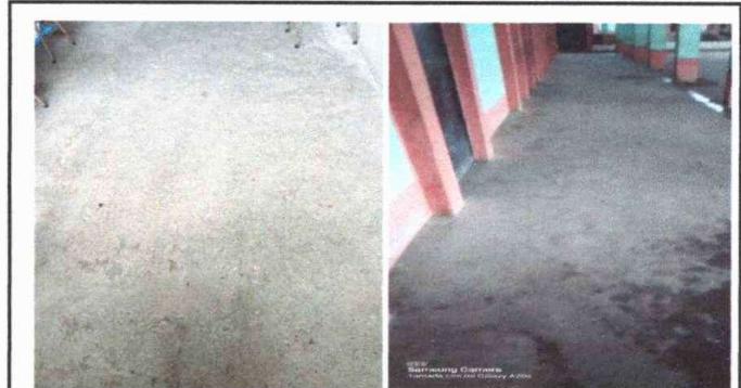
Foto 2 .Módulo 2: Sustitución de torta de cemento por piso cerámico
