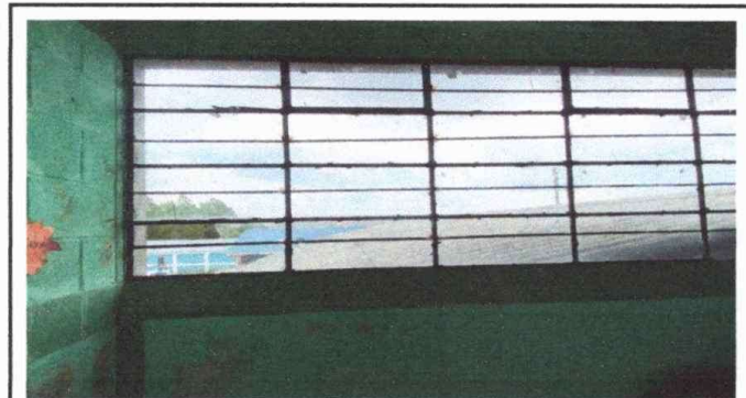
Foto 3. Módulo 2: Sustitución de ventanas de metal más vidrios
