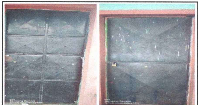
Foto 4. Módulo 2: Sustitución de puerta de metal
