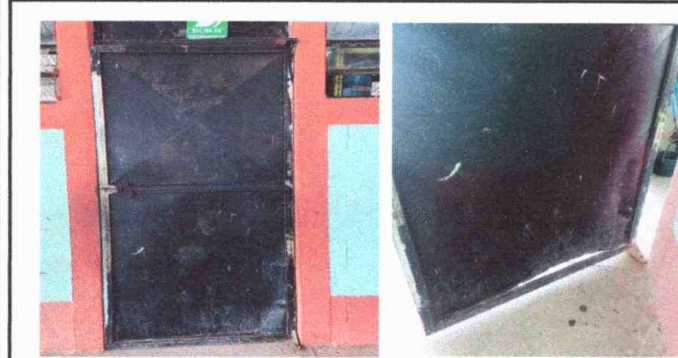
Foto 1. Módulo 1: Sustitución de puertas de metal
