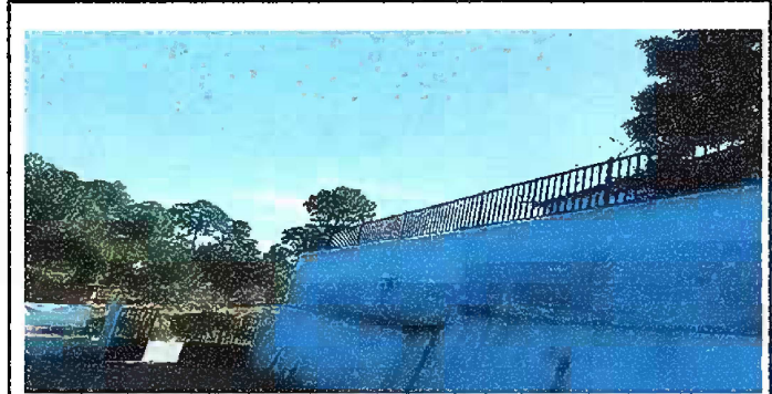
Foto 4: Módulo 3: Sustitución de Barrandas
