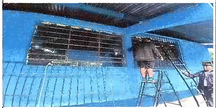
Foto 2: Modulo 1: suministro e instalación de balcon en ventana
