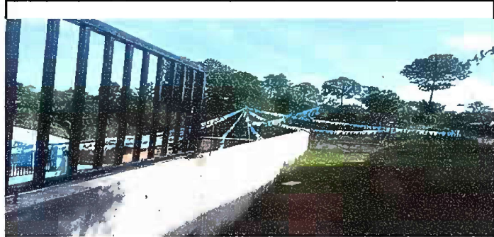
Foto 4: Modulo 3 Sustitución de Barrandas
