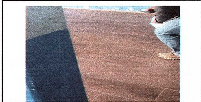
Foto 5: Reparación de piso por piso granito
