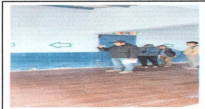
Foto 3: Reparación de piso por piso granito
