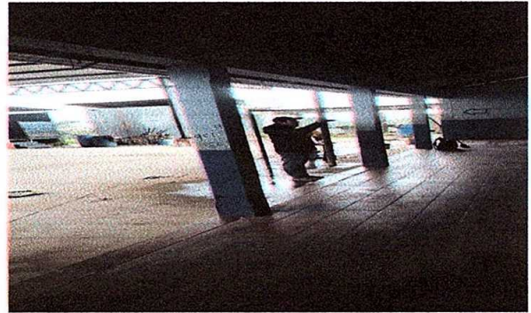
Foto2: Reparación de piso por piso granito
